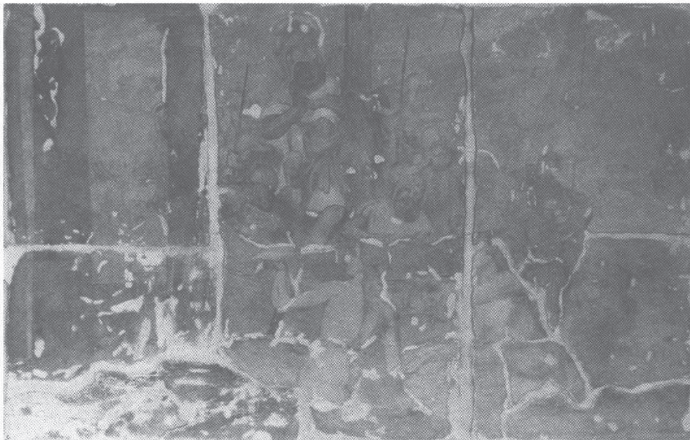
5. „Łódź Ulissesa i Syreny” – stan w trakcie konserwacji. Złożone pięć fragmentów malowidła w całość, podczas kitowania ubytków.
