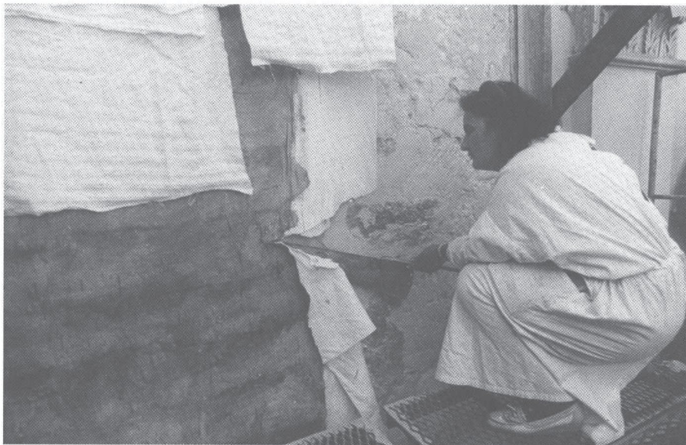
3. „Łódź Ulissesa i Syreny” – odcinanie malowidła od muru.
