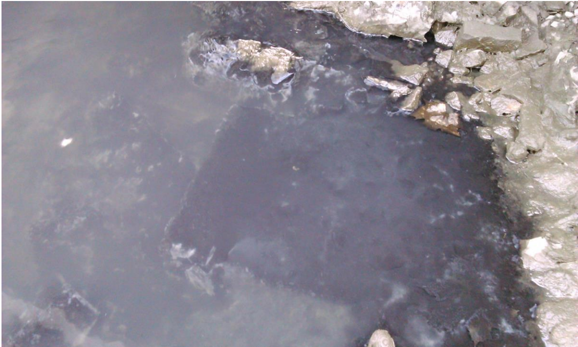
Fig. 7. Dno Potoku Służewieckiego przy ul. Przyczółkowej
