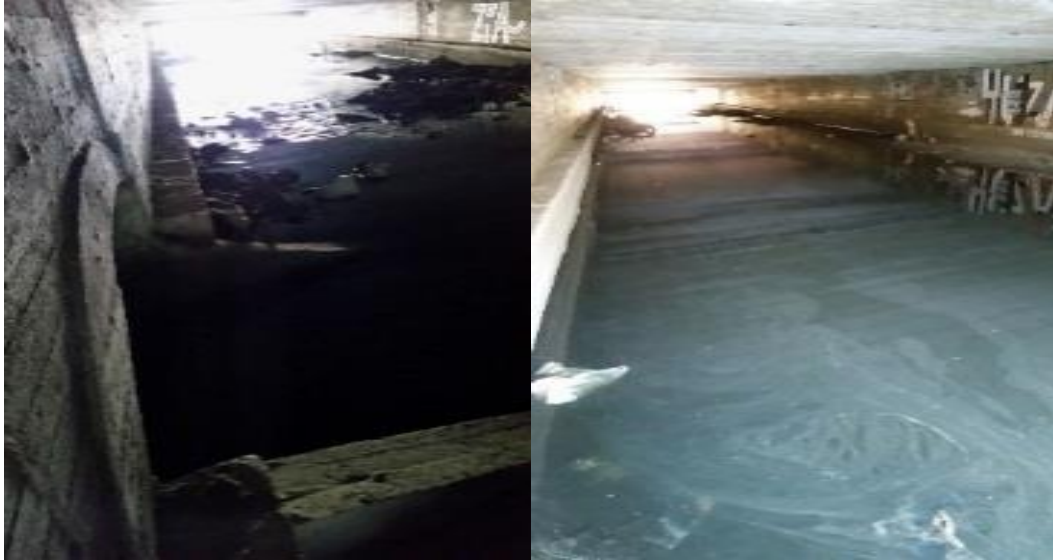
Fig. 12. Potok Służewieckiego płynący pod ul. Rzymowskiego. Woda brunatna / młeczna, wyczuwalny zapach „szamba” pod mostkami. Kilka odpływów.
